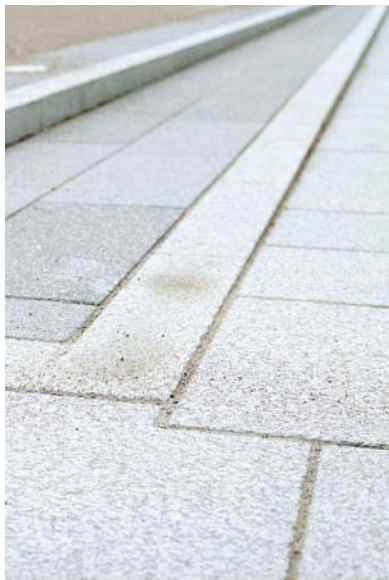
Treppenanlage: helle Stufen und dunkle Auftritte sorgen für Sicherheit
