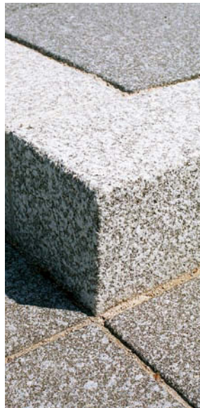
Der hellere Granit bildet die Stufen, der Auftritt ist aus dunklem Granit
