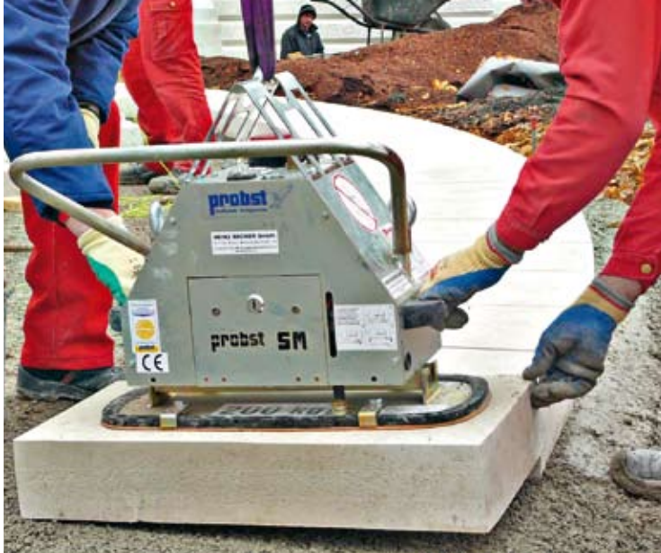
Präzisionsarbeit gefragt: Versetzen der Kalksteinplatten mit dem Vakuumgerät, fertige Fläche (rechts)
