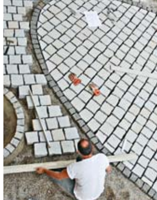
Aufwendiger Bau: Ellipse aus Altstadtplatten
