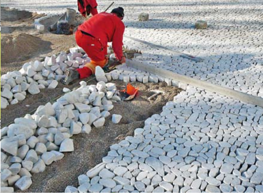
Kieselpflasterverlegung
